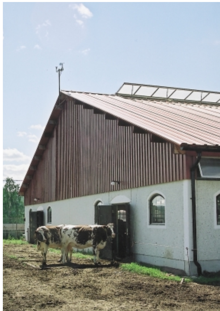
■ Nyfjaset på Hovgården er et pent bygg. Den automatiske luftinga på takmønet styres av en liten værstasjon.
