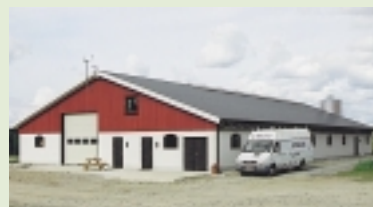
■ Nyfjøsset er fullisolert og med styrt ventilasjon i toppgavlen. Roboten kostet 1,3 millioner kroner, hele bygget 2,3 millioner.
