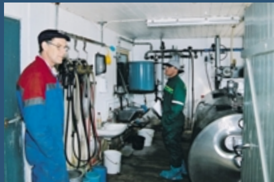
■ Stein Håvard Nymoen og prosjektleder Kjetil Lien (med plast-sokkene) ser på muligheter for ominnredning.
