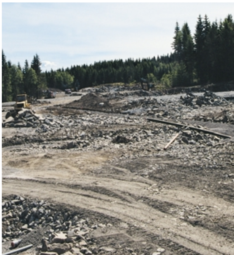
■ Byggetomta på Store Ree i midten av juni. Det første venteoksefjøsset skal stå klart 1. november i år.
