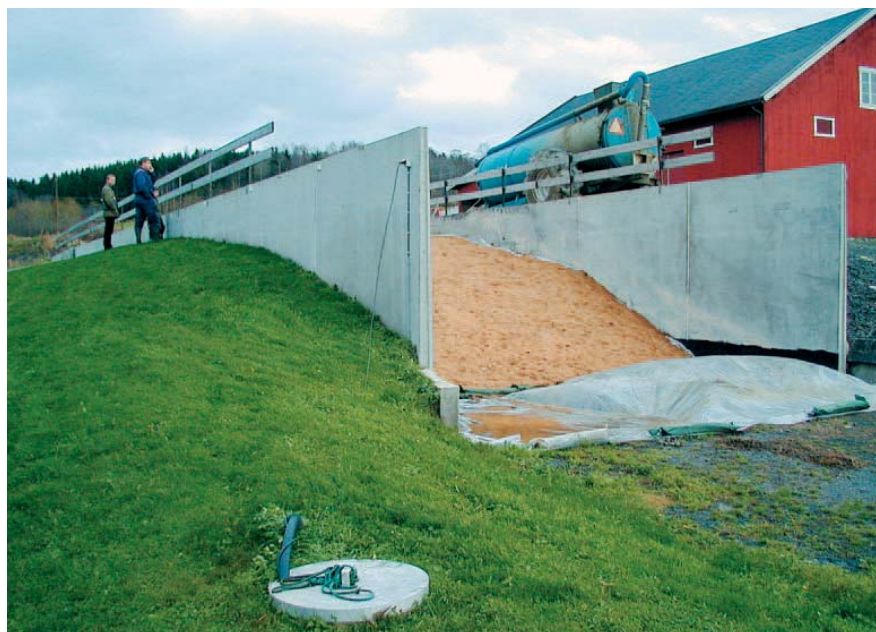
■ Tetting og overdekking av plasten er viktig. Til overdekking kan en for eksempel bruke sagflis. Avtakbart rekkverk sikrer mot fallulykker, og kan fjernes under innlegging.
