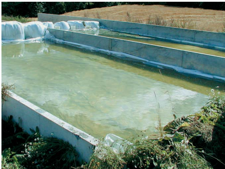
■ Vannbasseng gir både god tetting og press.
