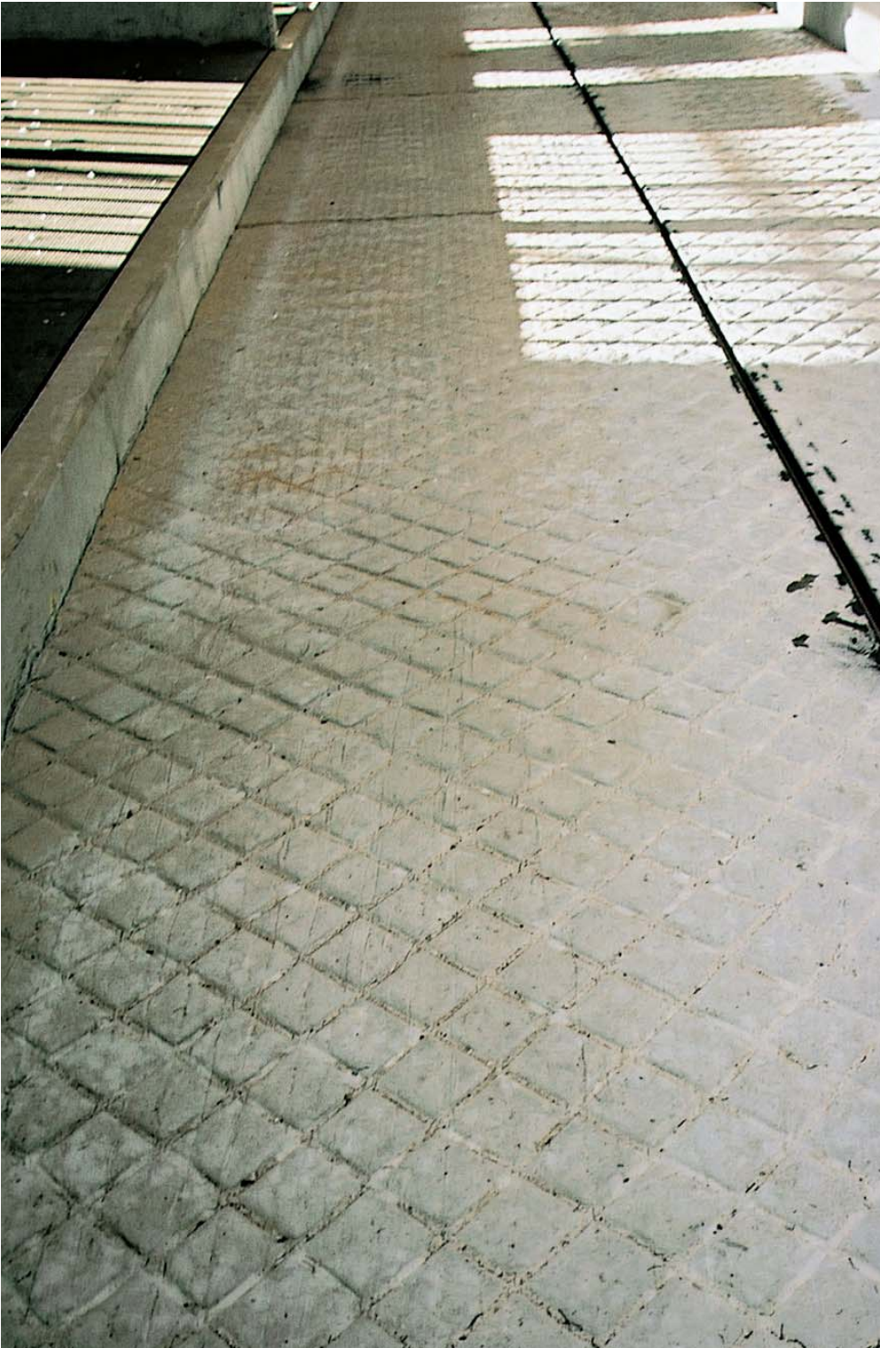
■ Mønstret overflate i golv for saktegående gjødseltrekk.
