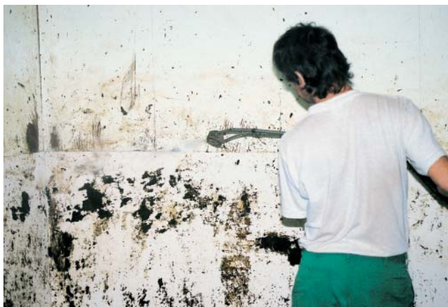
■ Når du skal vaske fjøset bør du bløtlegge flatene dagen før. Da løsner møkka lettere og du unngår sår og slitasje etter høytrykksspyling. Foto: Solveig Goplen
