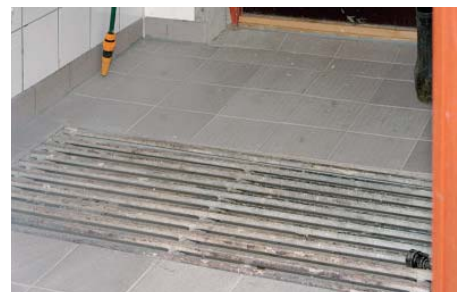
■ Sørg for godt fall mot sluk under rista slik at vann og møkk dreneres bort.
