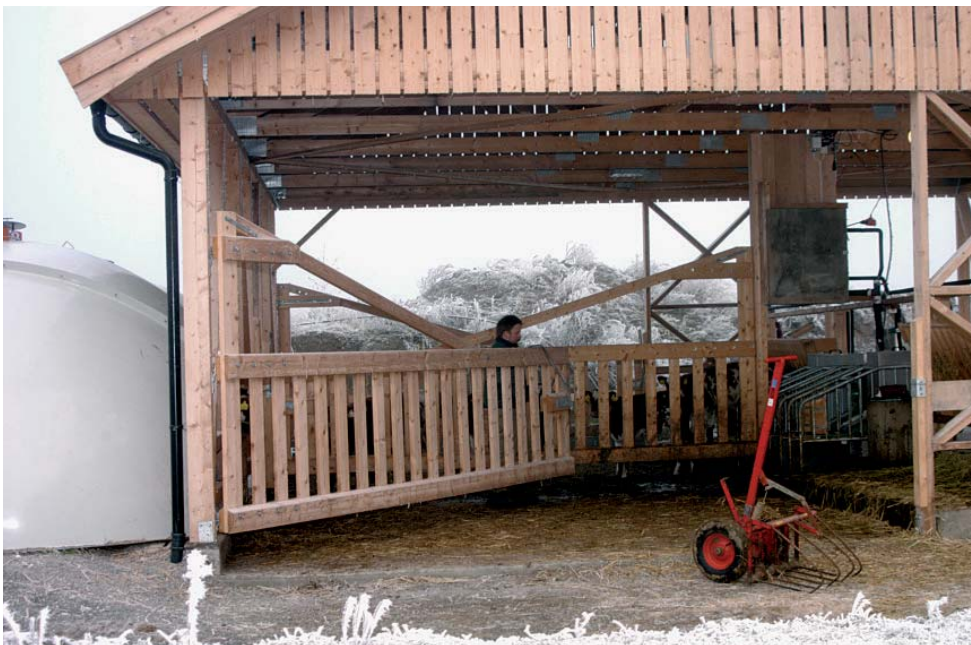
■ Et grindsystem i treverk gjør det lett å stenge kalvene inne i igloen når man for eksempel skal skrape møkk.
