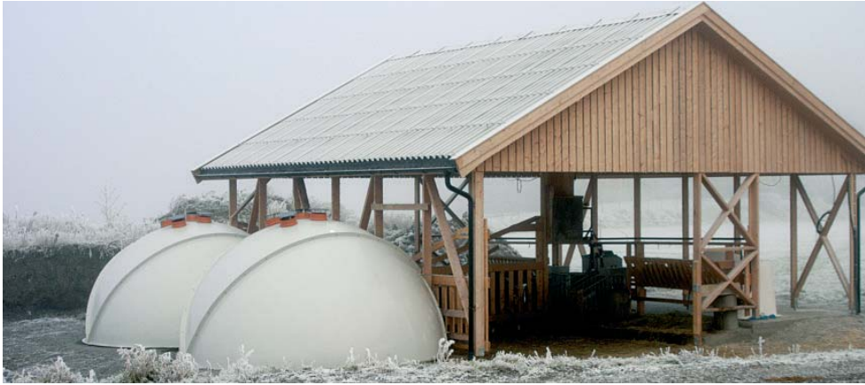
■ Det nye kalvefjøsset består av et stolpehus med skrapeareal hvor igloene er «koplet» inntil.
