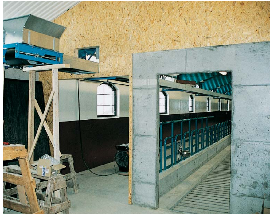
■ Med takmonterte utleggere kan fôrbrettene lages smale.
