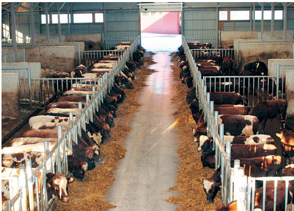
■ Bingene i venteoksefjøsset har to liggearealer med tråkkstalle. Et sekundært førbrett er plassert ut mot ytterveggen. Foto: Rasmus Lang-Ree.
