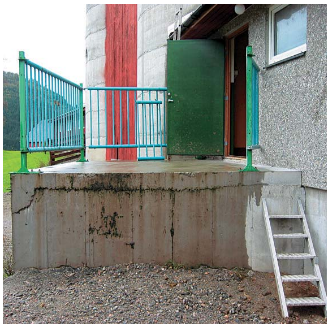
■ Rampen bør plasseres i enden av drivegang eller siste bingje. Anbefalt høyde der dyrebil skal rygge inntil er 0,6–1 meter. Foto: Anders Bergum
