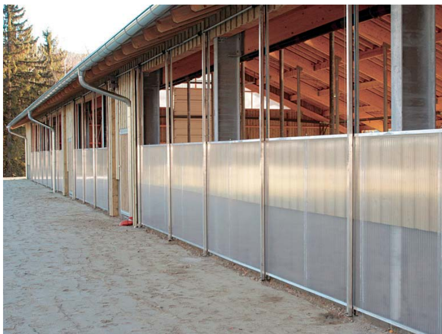
■ I tillegg til ventilasjon i mønet er det plastvinduer langs begge sideveggene som styres automatisk etter temperatur og vind. Hver langvegg styres uavhengig slik at det kan stenges på skyggesida, mens vinduene er åpne på solsida.
