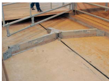
■ Hellende front er en dyrevennlig løsning som øker dyras rekkevidde på førbrettet og gir mindre trykkbelastning på bog.
