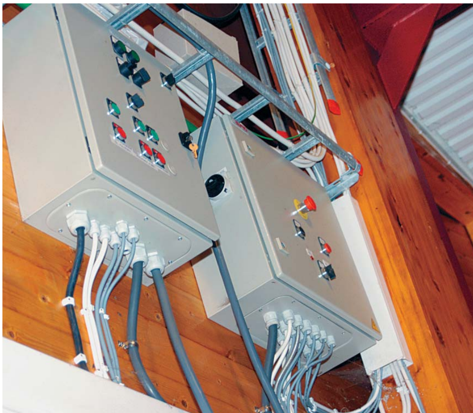
■ Fem av ti branner i landbruket skyldes feil med det elektriske anlegget. Kontroll av det elektriske anlegget skal gjennomføres minimum hvert tredje år. Foto: Rasmus Lang-Ree
