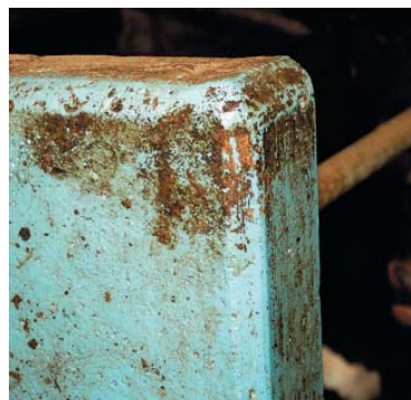
■ Avrunding av alle betongkanter er en viktig detalj for dyrevelferden.
