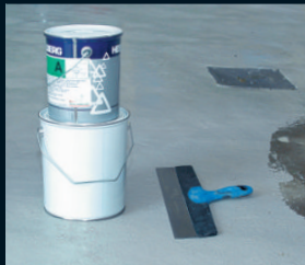
Utbedring av golv – side 24
