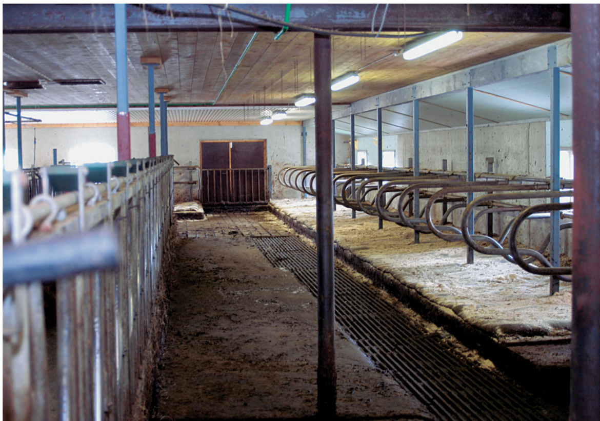
■ Flytting av sideveggen har gitt rom for liggebåser, samtidig som det gamle førbrettet fortsatt kan brukes.
