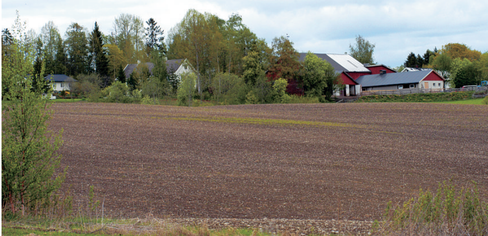
■ Lavbygget inneholder løsdriftsfjøset. Bygningen er forlenget med 7 meter og utvidet i bredden med 1,46 meter.
