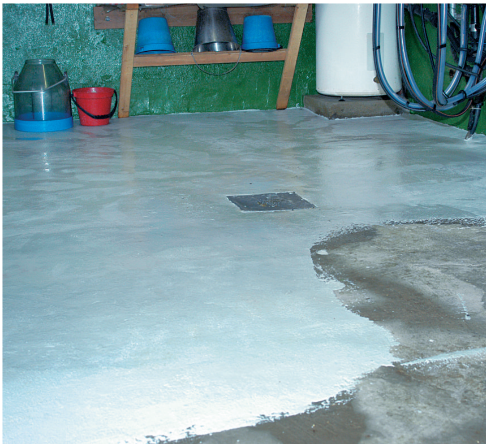
■ Her er en i gang med å legge epoxybelegg på gulvet i melkerommet etter at det først er lagt avrettingsmasse på det gamle betonggolvet. Foto: Rasmus Lang-Ree
