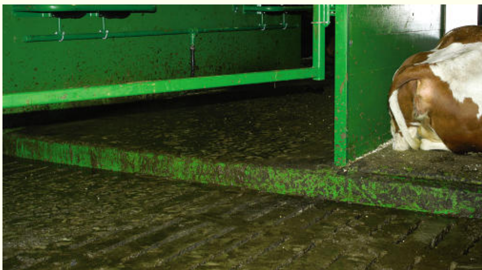
■ Golvet i tverrgangen mellom sinku- og melkekuavdeling støpt i samme nivå, for at nivåforskjeller ikke skal være en hindring for å gjøre om tverrgangen til liggebåser. Bredden på tverrgangen er dimensjonert for fire liggebåser.
