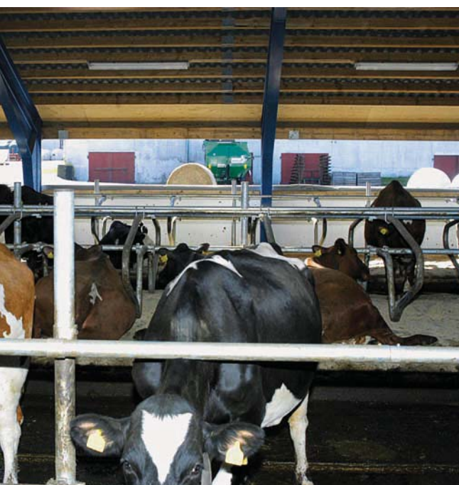
■ For Stig Gammelsrød ble kostnadsbesparelsen avgjørende for valg av uisolert fjøs. Når gardinene langs langveggene er oppe blir det så åpent og luftig at en nesten ikke har følelsen av å være inne i et fjøs.
