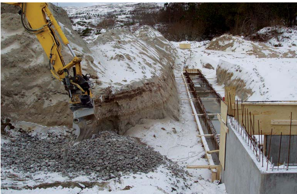
■ Pumpekum og tverr-renne under arbeid. Foto:Terje Storsul.
