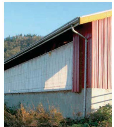
■ Vegger med automatisk styrt gardinventilasjon er den vanligste måten driftsbygninger bygges på i Canada i dag.
