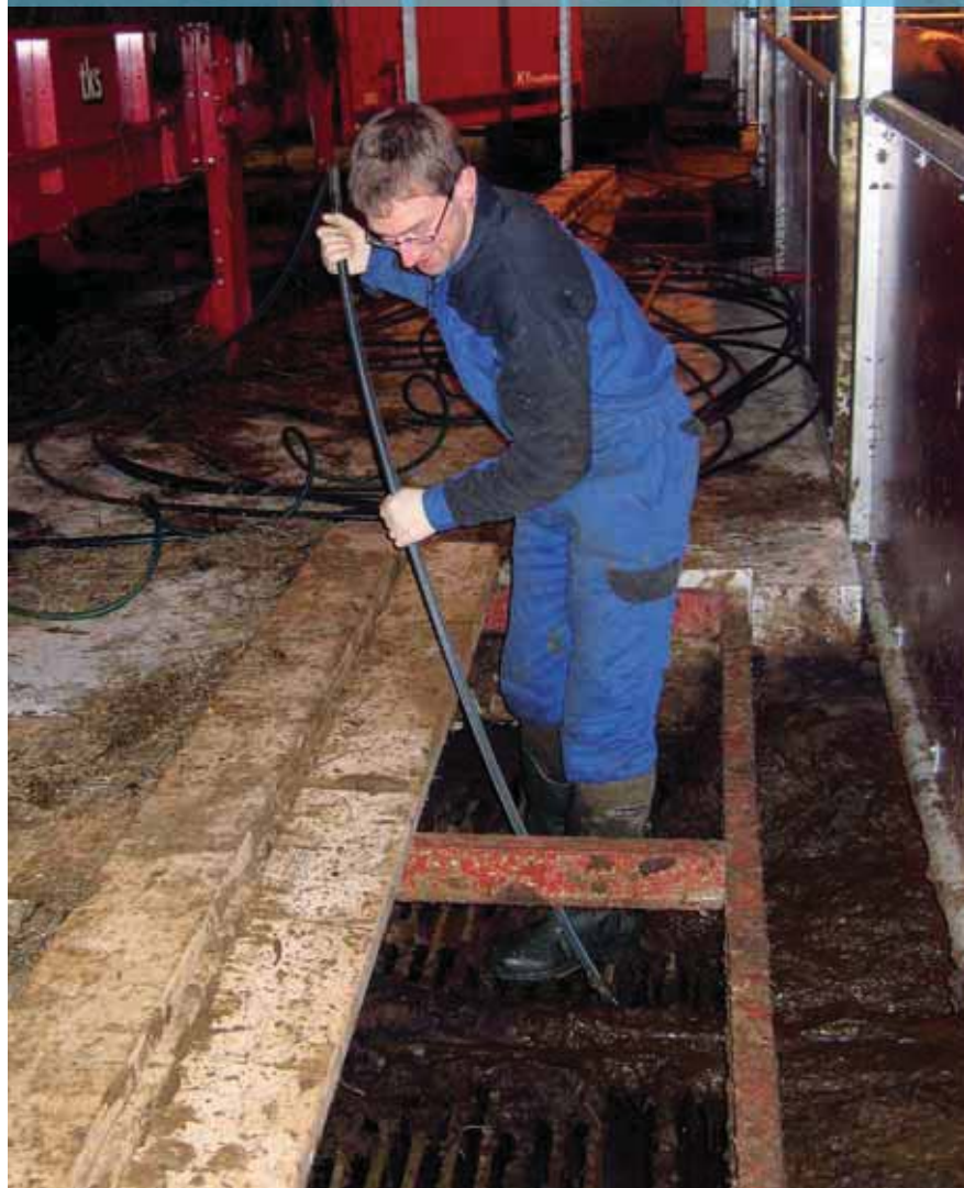
■ Artikkelforfatteren spyle opp dreneringa under ei gjødselrenne. Foto: Marit Gundersen Skjærvik.
