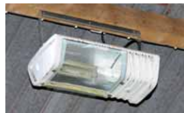
■ Belysningssystemet Agrilight sprer lyset godt, og det var det nok med 22 lamper mot 155 lyspunkt hvis de hadde valgt tradisjonelt armatur. Fra klokka ti på kvelden til seks om morgenen slår den spesielle rødlige nattbelysningen til Agrilight seg på og det har fungert bra. Av 70 kyr er det 50 som er innom roboten i løpet av natta.
