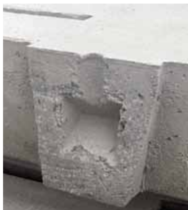
■ To element lagt på plass. Der tverrribbene møtes ses et hull for å fylle mørtel i utsparingen som skal gjenstopes.
