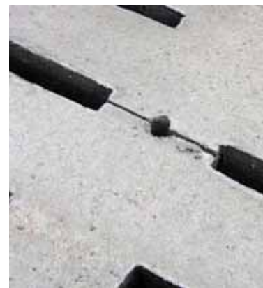
■ Spaltegolvelementet sett mot ende av tverr-ribbe. Se grop i enden av ribba som skal støpes igjen etter montasje.
