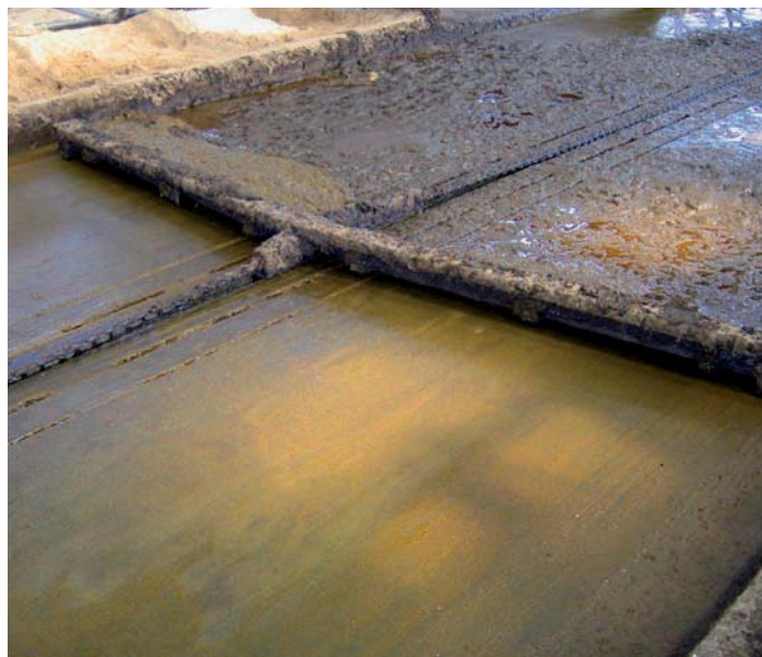
■ Spaltegolv med langsgående drenerende kanal. Foto: Mads Urup
