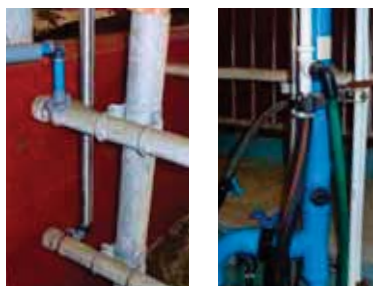
Sparing av energi ved forvarming av drikkevann og forkjøling av melka, var finesser vi fant.
