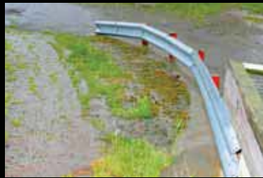
Rekkeverket på låvebrua er for lavt.
