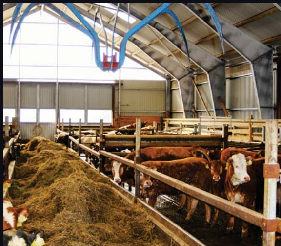
Dette storfekjøttfjøset ble bygd i 2004. Et kaldfjøs med liggebåser og oppvarmet skapeareal.
