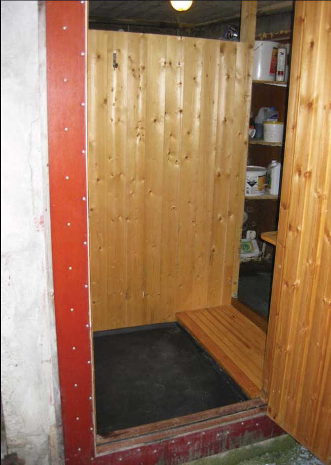
Sluse i eldre fjøs, sett fra utsiden.
