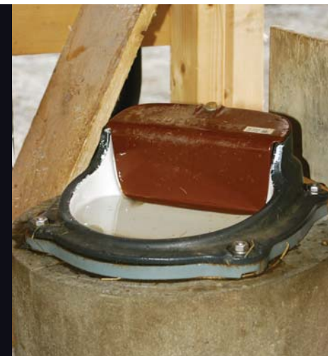
I kaldfjøs er det nødvendig med frostsikret drikkevannssystem. Foto: Rasmus Lang-Ree.
