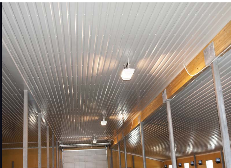
Lysopplegget må sikre minimum 200 lux 16 timer i døgnet. Foto: Rasmus Lang-Ree
