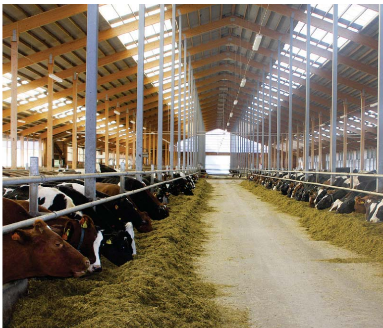
Kufjøset måler 155 x 36 meter. Det har seks meter bredt kjørbart fôrbrett og fire avdelinger med plass til inntil 160 kyr i hver.
