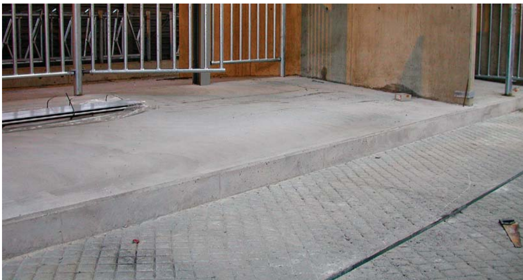
Lasse Gravås mener det har utviklet seg et betongdiktatur når det gjelder husdyrbygg i Norge. Både byråkrater og entreprenører har bidratt sterkt til «sløsingen» av betong. Foto: Jan Arve Kristiansen
