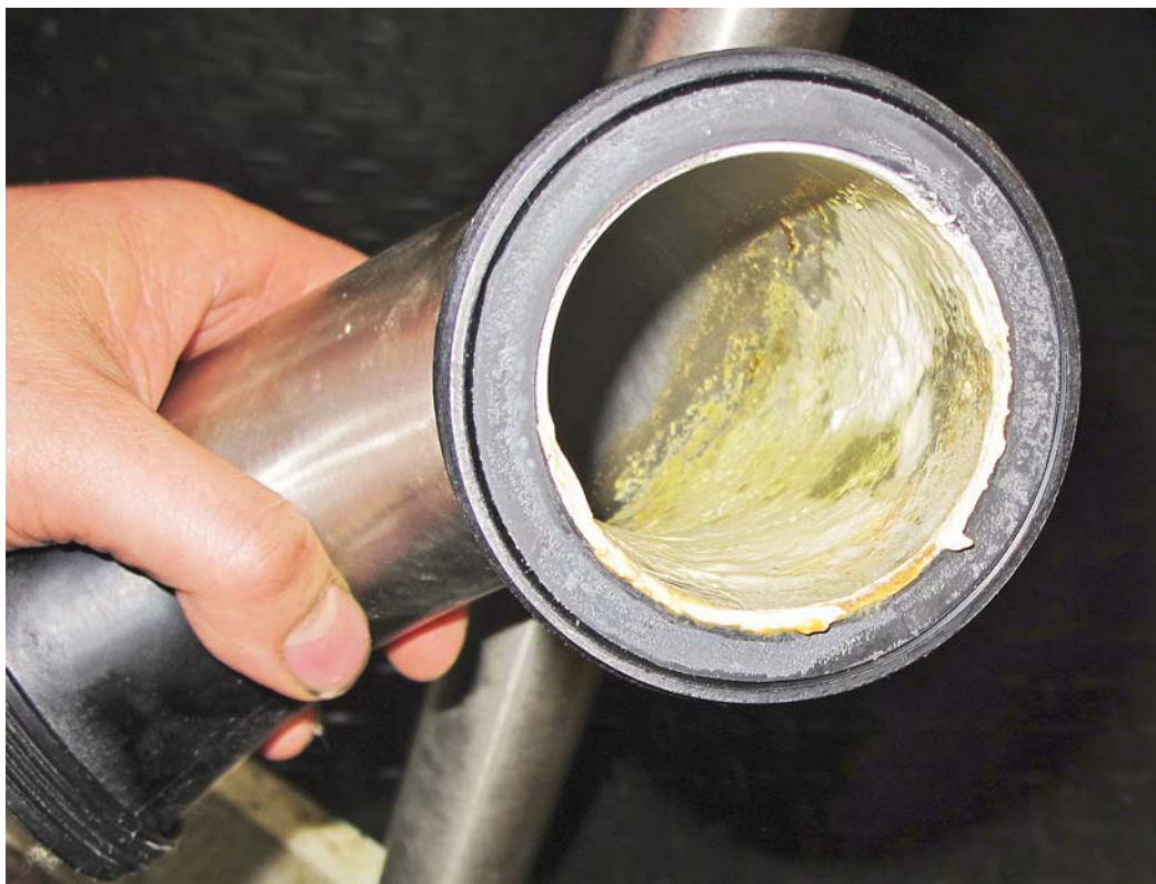
Slik så det ut inne i melkeledningen i en del som ikke ble vasket på grunn av feil konstruert vaskeopplegg. Det er ekstremt store mengder belegg i ledningens overside. Foto: Odd Rønningen
