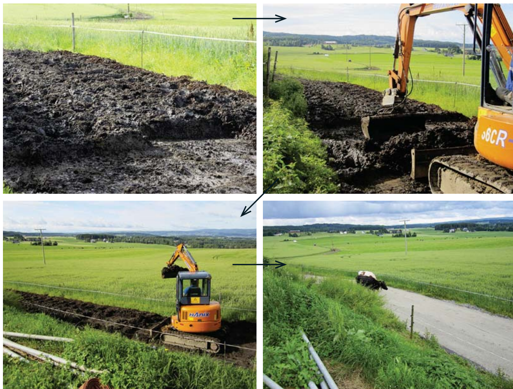
Billedserie som viser hvordan bygginga av drivveg ble utført – fra gjørmehav til kuautostrada. Foto: Guttorm Ingberg
