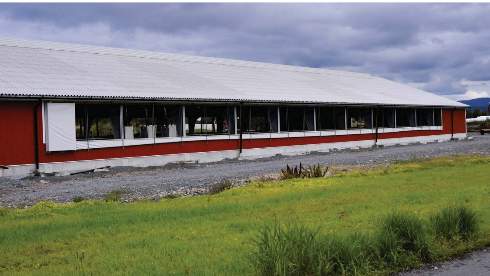
Fjøs med åpne vegger som kan lukkes med gardiner i Elnesvågen i Møre og Romsdal. Foto: Rasmus Lang-Ree
