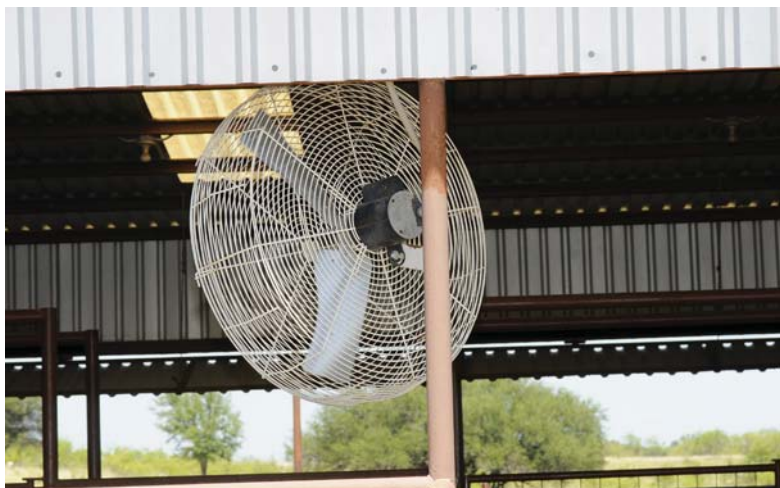
Vertikale vifter flytter masse luft. De fungerer bra i et høyt og ikke for bredt fjøs. Forutsetningen er store nok åpninger ut. Foto: Rasmus Lang-Ree
