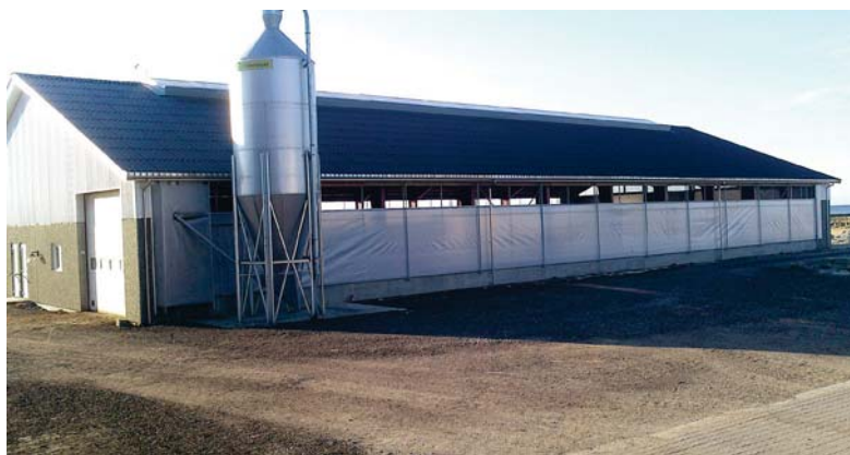
Sideveggene på fjøset er heile 4,20 meter høge med 2,90 fri høgde til gardin. Dette er ein meter meir enn det som er vanleg og det slepp inn svært mykje ljøs og luft. Det er heller ikkje montert fuglenett. Foto: Privat
