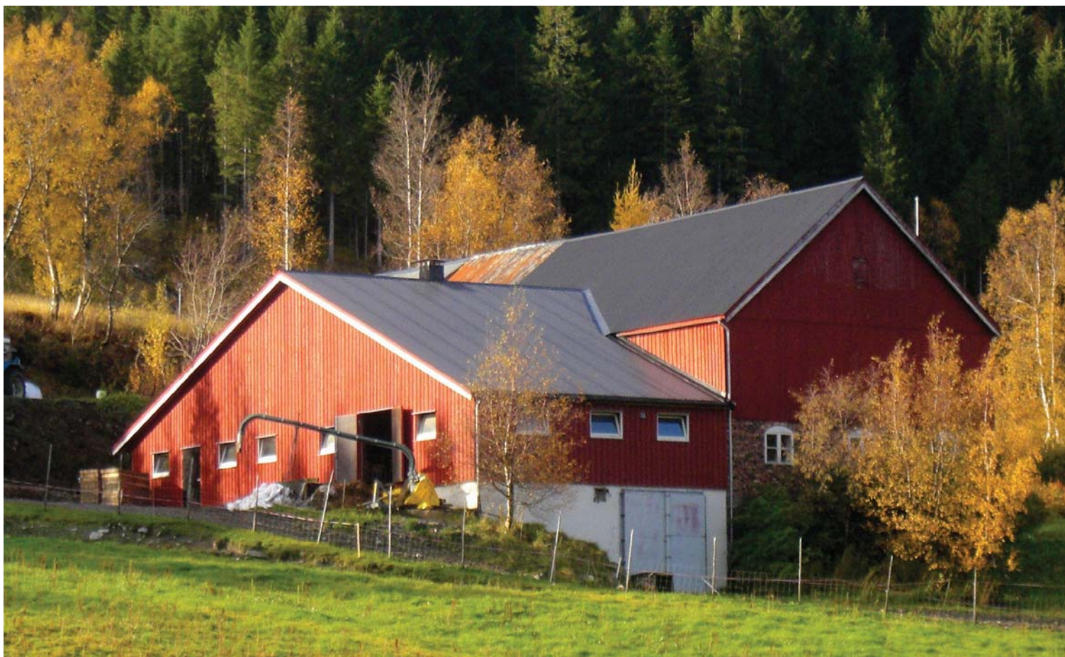
Pilotbruket hos Mari og Geir Arne Kosberg i Roan etter endt utbygging. Eldre tilbygd båsfjøs er utvidet i bredden for å få plass til liggebåser og mosjonsareal. Foring ved eksisterende førbrett. Foto: Per Olav Skjølberg
