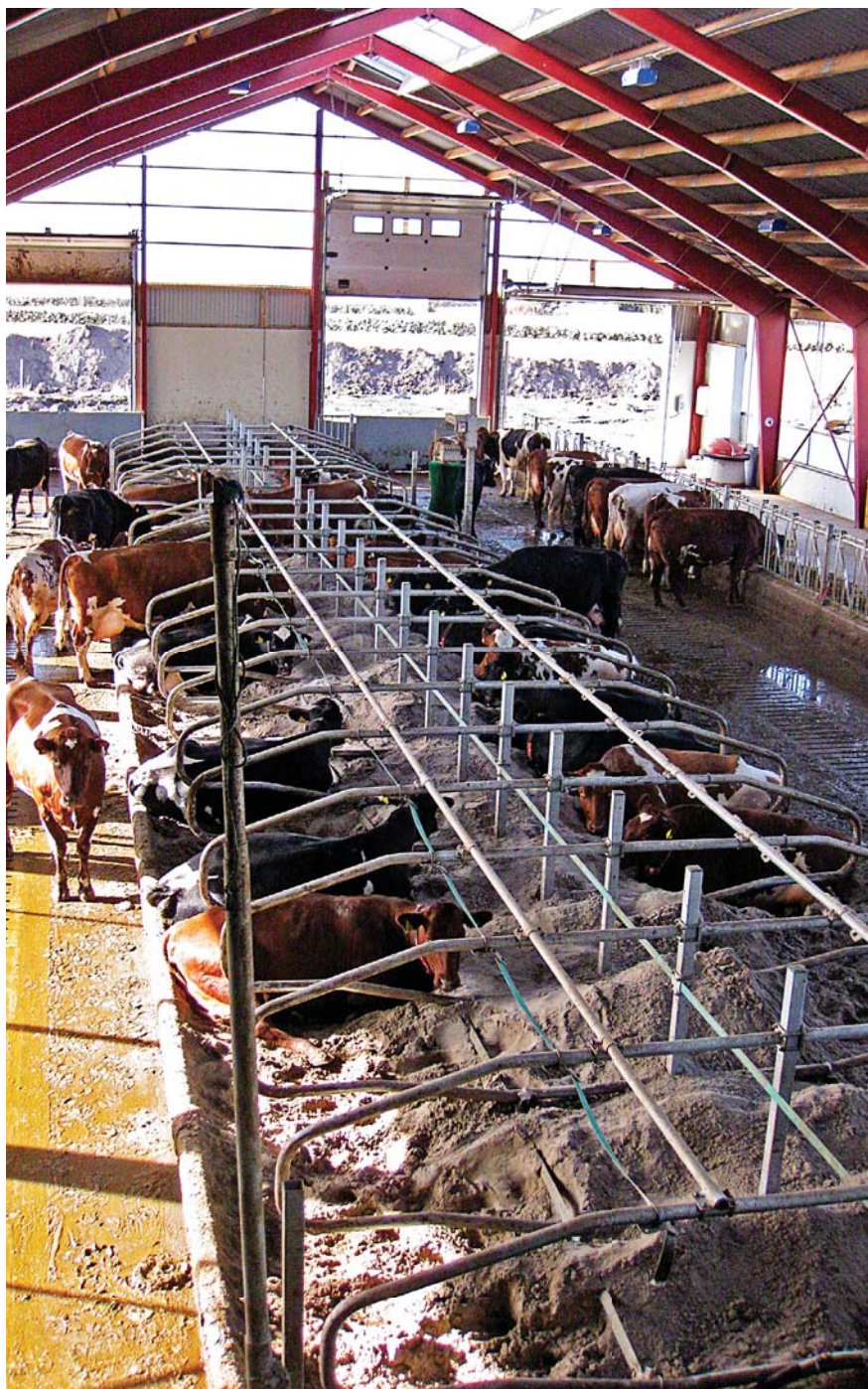
Fjaset har tri rekkjer med liggebåsar, i tillegg er det plass til fråskiljing og kalving på baksida av roboten. Sideveggene på fjaset er heile 4,20 meter høge med 2,90 fri høgde til gardin. Dette er ein meter meir enn det som er vanleg og det slepp inn svært mykje ljøs og luft. Det er heller ikkje montert fuglenett. Foto: Inga Skretting
