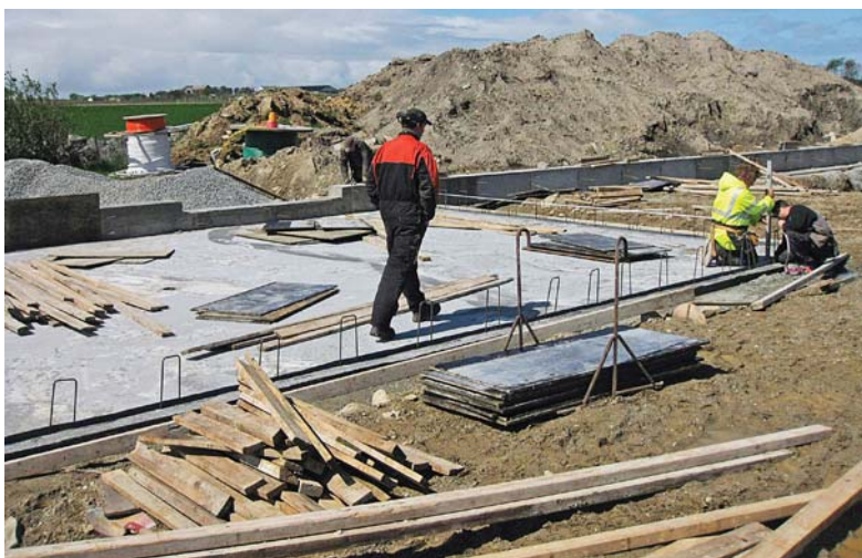
Fjøsbygginga er i gang. Her er golvet i kalvingsgarden og ringmuren støypt.
