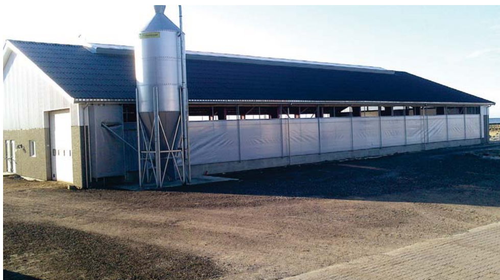
Frittstående nybygg kun for mjølkeproduksjon hos Andreas Joa på Jæren (se egen reportasje på side 38). Foto: Inga Skretting
