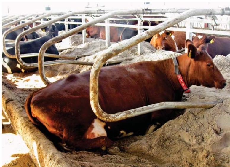
Kyrne likar seg godt i det mjuke underlaget. Golvet i båsen er jamhøgt med gangarealet, bakkanten er støypt opp om lag 35 cm for å halda sanden på plass. Foto: Inga Skretting
