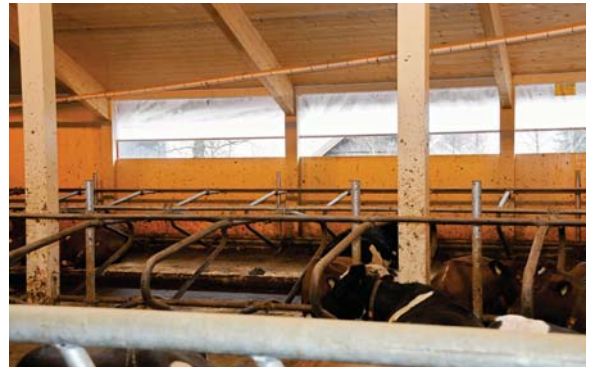
Delvis åpne vegger (som kan stenges med vindbremsduk) gir god gjennomlufting.
