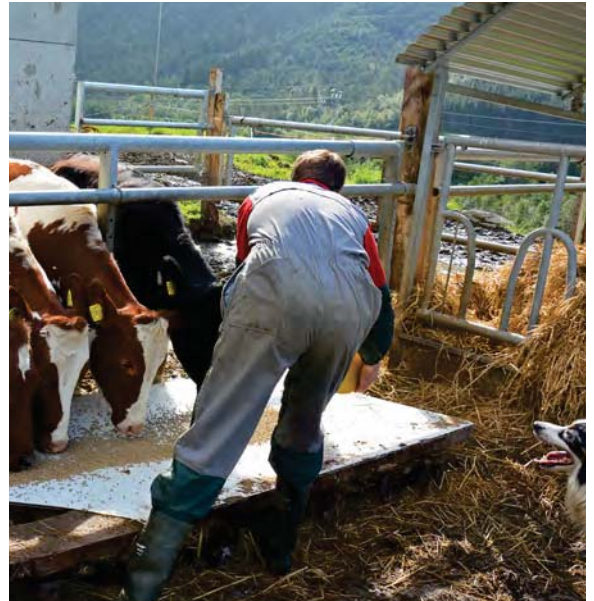
Under fjøset er det binger til kviger og sinkyr og med utvendig eteplass. Neste byggeprosjekt er tak over utearealet.
