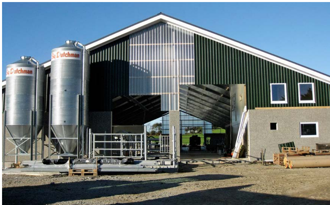
Brystveggen som vender mot sør og innkøyringa. Porter mangler framleis. I framgrunnen utlastingsrampe. Isolert avdeling i høgre hjørne på biletet.
