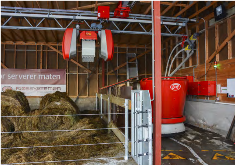
Fôrlager brukt til avfallsfôr er ombygd til fôrkjøkken. Fôrkjøkkenets fylles hver tredje dag.
