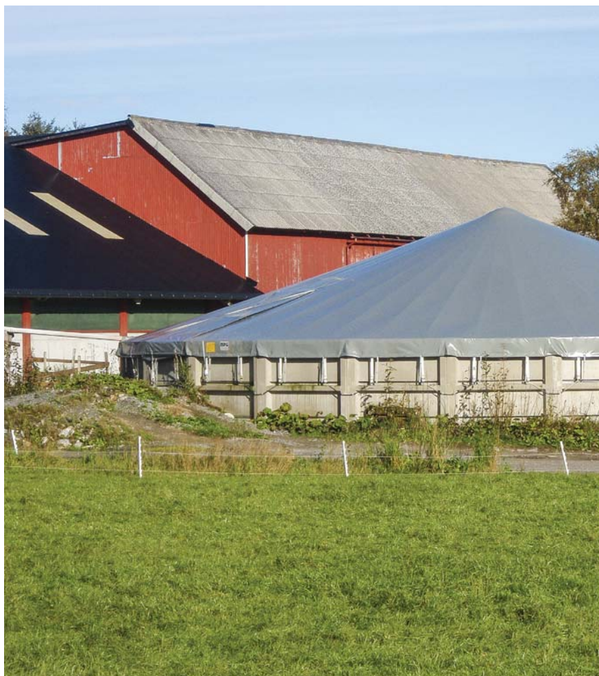
Tak over gjødselkummen er en effektiv måte å øke lagerkapasiteten, men det koster. Foto: Oddbjørn Kval-Engstad
