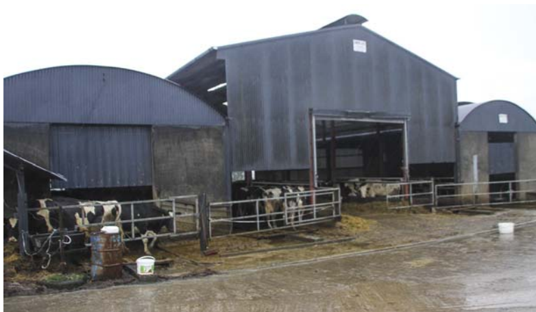
Bygninger er enkle i Irland. Fjøsa er uisolerte og det er heller ikke dører inn til det kjørbare forbrettet. Det måler ca 5,5 meter i bredden. Samme avstand er det også mellom stålbuene som bærer fjøset.
