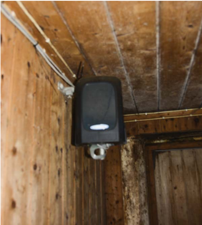
Antenna er ved utgangen til beite og klarer å fange opp signaler også bak en betongvegg med åpning for fôrvogna
