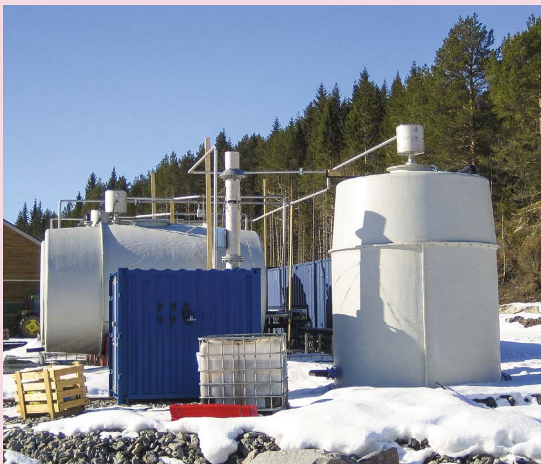
Biogassanlegget på Tingvoll gard under bygging. Fra venstre: Liggende glassfibertank til utråkning (gjæringstank), blå kontainer med fakingstærn til gassrensing, blå kontainer til diverse pumper og rør (i bakgrunnen), og stående glassfibertank til nedkjøling av prosessen (kjøletårn). Tankene er senere isolert, og anlegget bygget inn.
