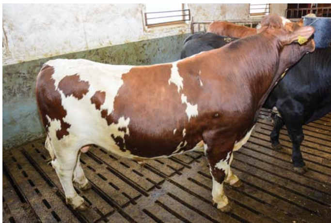
Quattroplank er fire spalteplanker i samme element. Det gir stor stivhet som tillater stor lysåpning. Tråflate på 11 centimeter og avstand mellom spaltene på 4 centimeter gir prosentvis svært stor lysåpning. Ulempen er at elementene blir svært tunge og Wvt Betongprodukter på Rindalsskogen har gått over til å produsere trippelplank.
