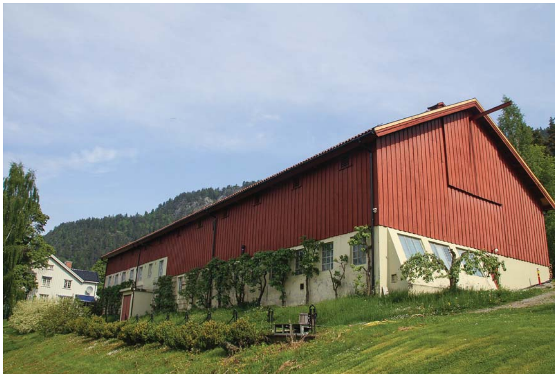
Gården Tunga har bevart det arkitekttegna gamlefjøset fra 1938. Gården ligger med vid utsikt mot Heddalsvannet, og har vært i Ole Holta sin slekt siden 1792.
