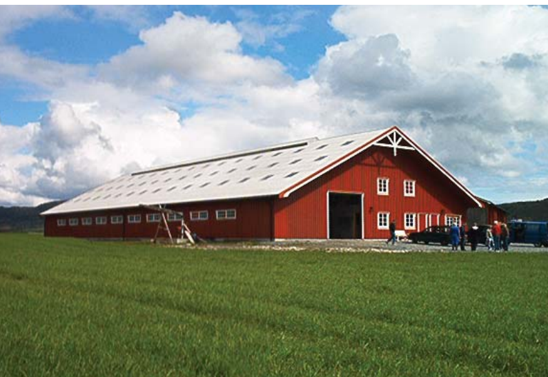
Ny driftsbygning for mjølkeproduksjon. Foto: Per O Skjølberg
