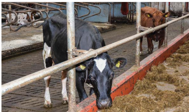
Spaltegulvselement med skråstilte spalteåpninger. Vanlig med plankebredde på 80–90 mm og spalteåpning på 30–35.
