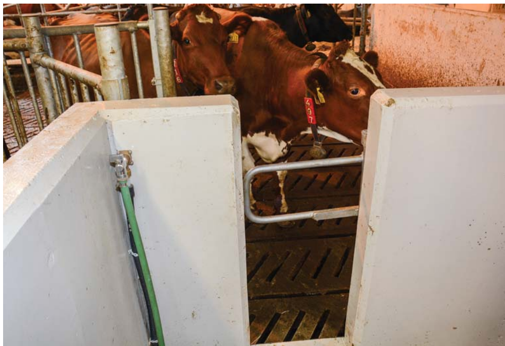
Smart lukkemekanisme i mann hull (enveis vippemekanisme). Spylemulighet på dette punktet er en viktig detalj.
