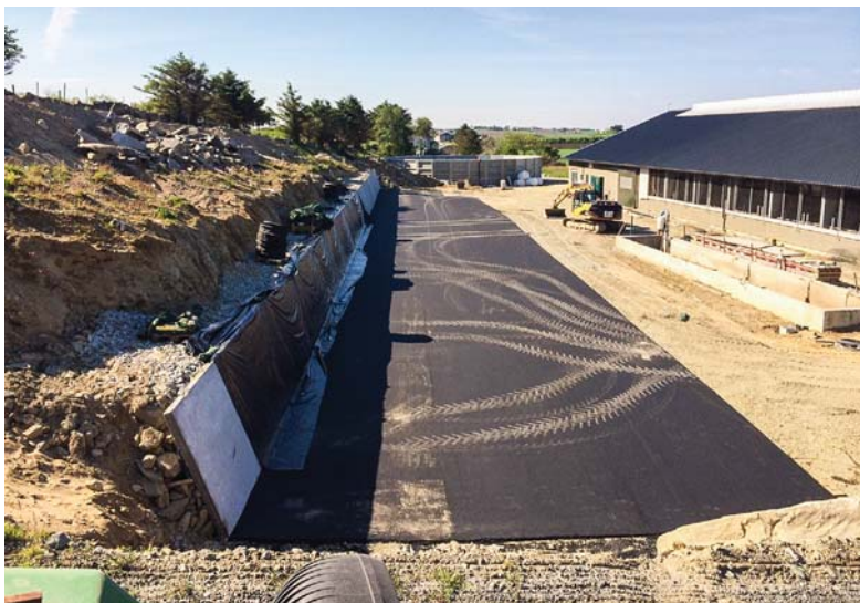
Nyinfalvert plansilo klar til bruk. Veggjen til venstre er sett opp av ferdige element som står faststøytte nederst og kviler på stein og pukk. Foto: Inga Skretting.
