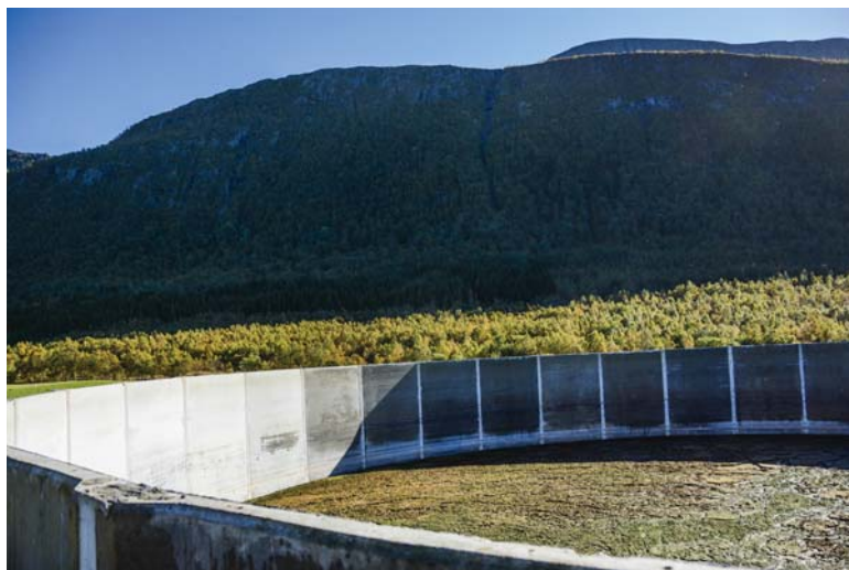
Møkkummen rommer 1800 kubikkmeter (totalt 2500 kubikkmeter som kjøres ut fra kum og fra kjeller i gammelfjøs) og er åpen for å ta vare på mest mulig regnvann. Tynn møkk er svært optimalt, da kan den og spres i godværsperioder. 1500 millimeter er forventet nedbørnivå i Steigen.
