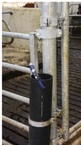
Einar Kiserud ønsker å bli best på egenproduserte råvarer til mjølkproduksjon. Det nybygde fjøset hadde noen spennende detaljer, som slike spylepunkt ved hvert mannehull. Foto: Solveig Goplen
