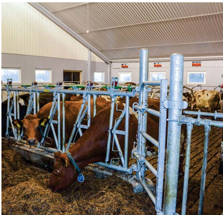
Bygget ferdigstilles i høst og brukerparet har lagt vekt på å sørge for å ha ett eget overskudd til å ta tak i drifting av «nyfjøset».
