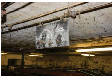
En enkel sak som tavle over bingen med antall «sveiv» på kraftfôrvogna gjør det enkelt for den som steller.
