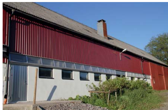
Innertaket i gamlefjøsset ble løftet 60 cm og oppløftet brukt som veggventiler.
