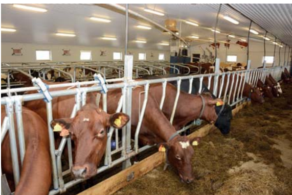
To-rekkers fjøs med førbrett mot yttervegg og to kraftførautomater. Trøndelag Forskaling sto for betongarbeidet, innleide håndverkere til trearbeider og Felleskjøpet har levert innredning.
