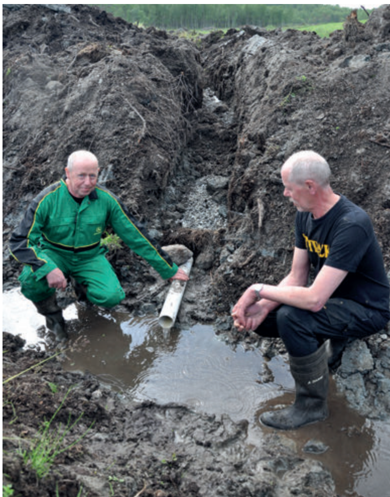
- Vi liker grøfting fordi vi ser raske resultater, sier Sverre (til venstre) og Gudmund. Grøfta på bildet ble ferdigstilt samme dag som bildet ble tatt.
