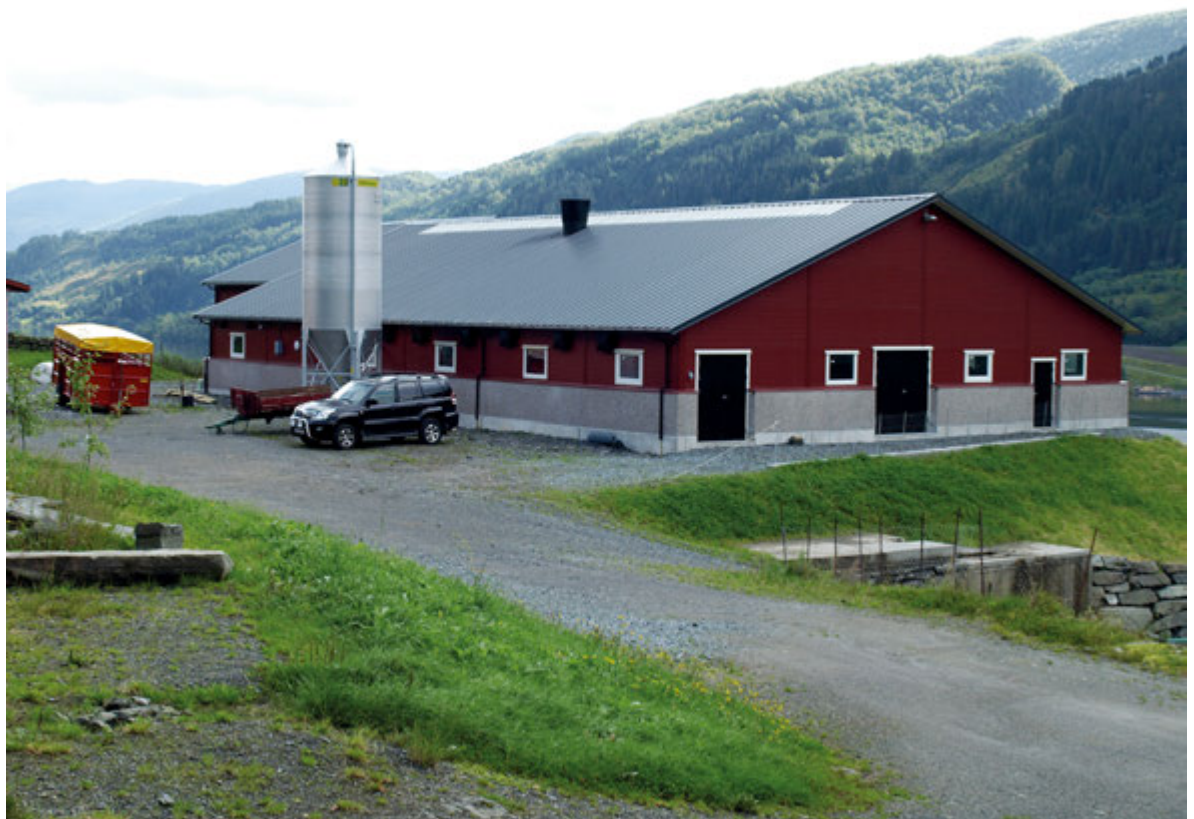
Den nye fjøsen på Laukeland ligg fint i tunet. Til høgre kan me sjå litt av gjødselkjellaren til gamlefjøsen som fortsatt er i bruk.
