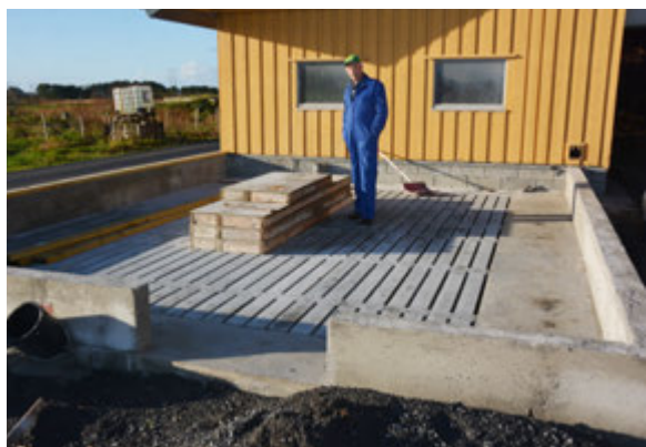
Byggingen av nytt kalvefjøs i forlengelsen av fjøset er allerede igangsatt.
