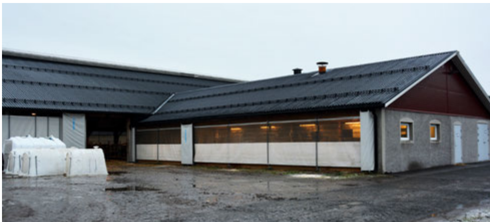
Kalveføset med gardiner med vindbremsduk i ene langveggen bygd i vinkel på kufjøset. I hjørnet åpning til kalvingsbinge med djupstrø. Blir også brukt ved levering av dyr til slakt.
