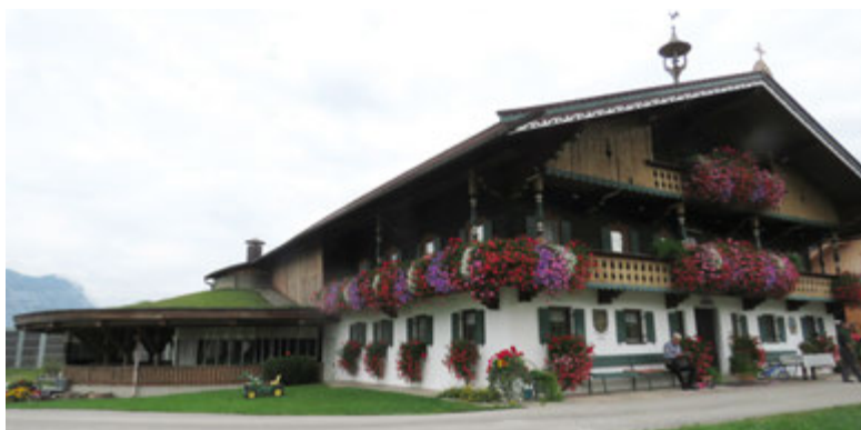
Schwoicherbauer i Wörgl har integret fjøs/bolig der fjøsdelen er restaurert/nybygd.
