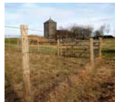
Gjerde ned stor strekkfasthet satt opp i 2014 på Avaldsnes Karmøy. Det er brukt 14 centimeter hjørnestolper og 8 centimeter på strekkene.
