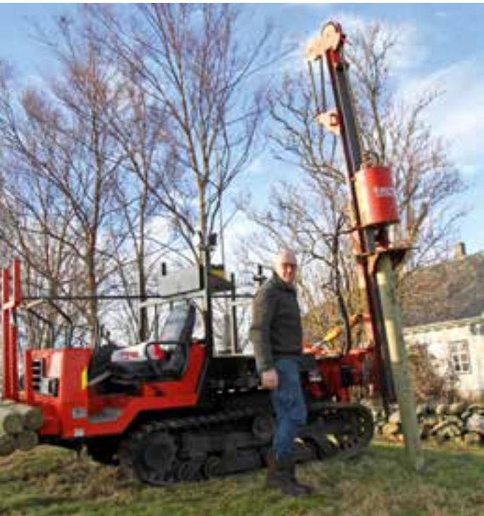
Fra England har Ragnar Vikingstad hentet beltegående gjerdemaskiner ombygd fra gamle gravemaskiner. Disse har hydraulisk bom både for å lage hull i bakken og å slå ned staur.
