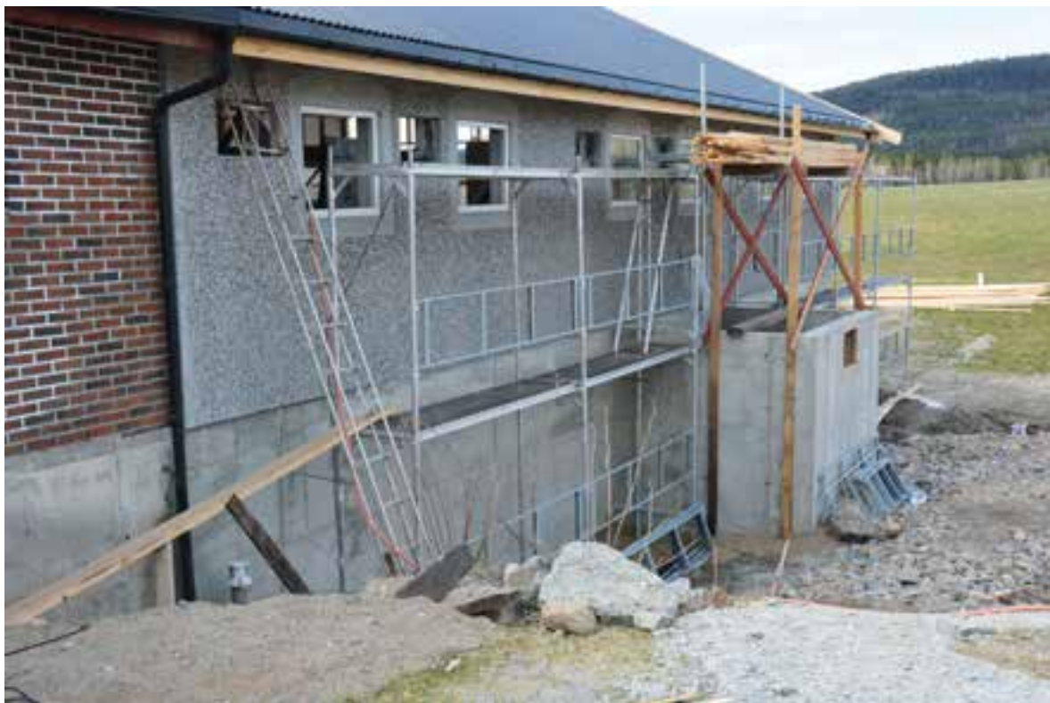
Grundig forarbeid og godt gjennomarbeidede planer for byggestart reduserer risiko for forsinkelser, kostnadsoverskridelser og feilvurderinger av egeninnsats. Foto: Rasmus Lang-Ree
