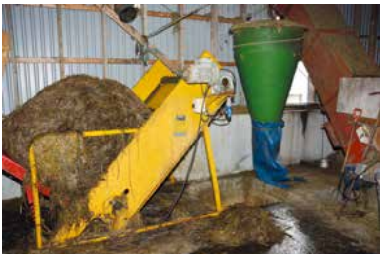
Med støpt dekke over nyfjøset ble det plass til siloriver og mye lagerplass i etasjen over.
