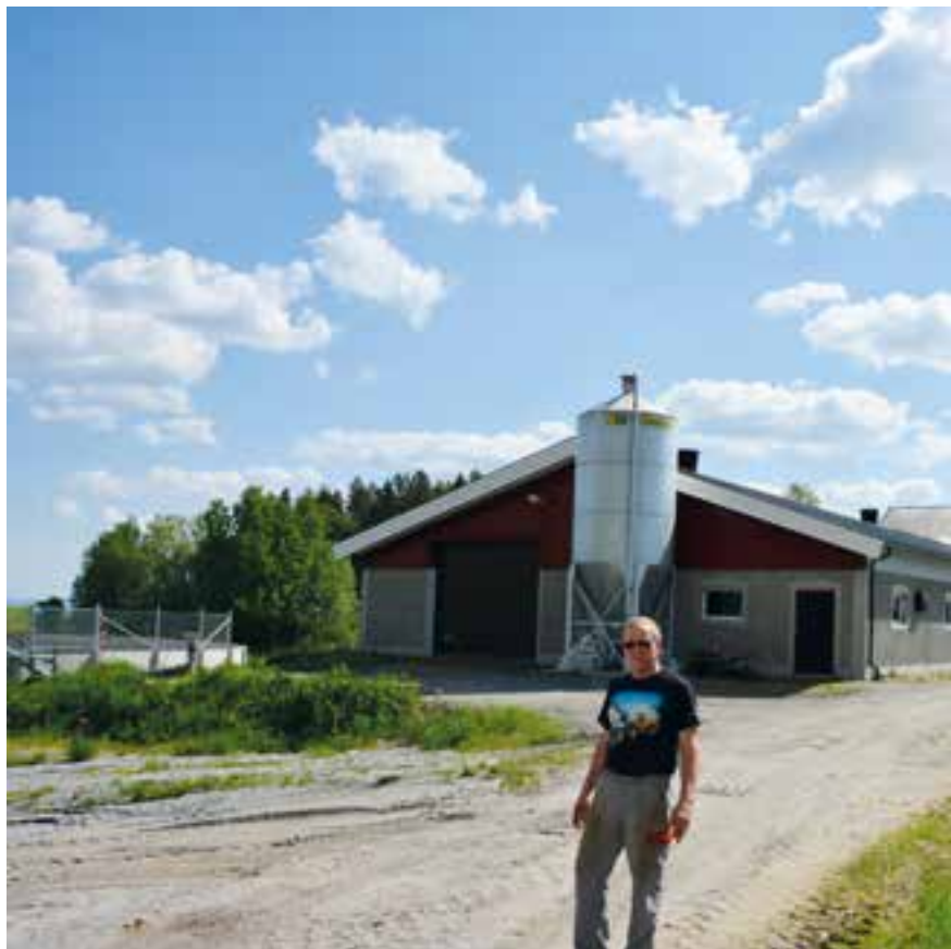
500 kvadratmeter ny driftsbygning gjør det mer interessant å ta over eller eventuelt lettere å få solgt på det åpne markedet.
