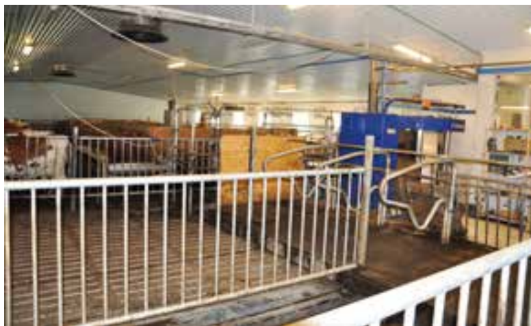
Sykebingen, nedsenket robot, kontor, tankrom og et teknisk rom befinner seg i den nye enden av fjøsboligen. Spalteplank også her med flyterenner som tar gjødsla over i kjelleren.
