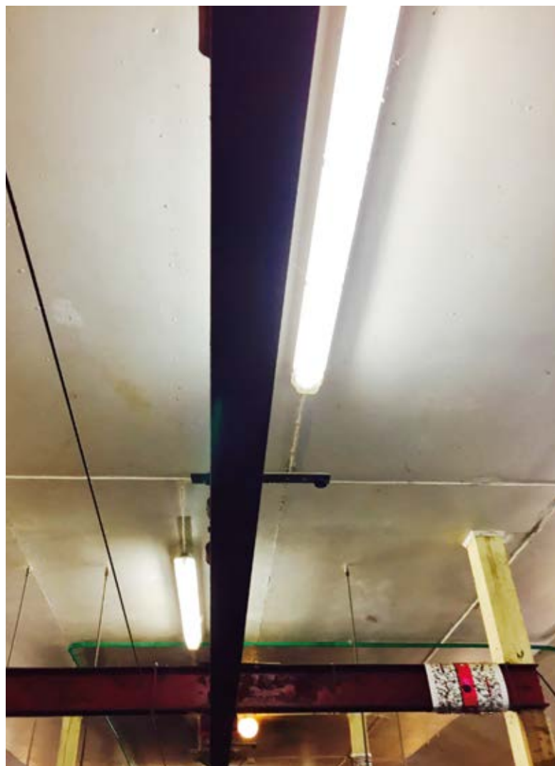
H-bjelken skyggar for lyst, og meir lysrør må monterast opp for å motverke dette.
