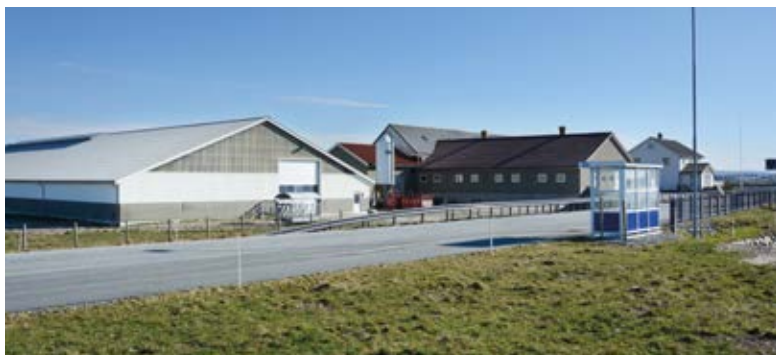
Ammekufjøsset til venstre. Til høyre for ammekufjøsset tilbygget til kufjøsset som er bygd i vinkel på det gamle fjøsset. Beitet til melkekyrner er på baksiden av kufjøsset.
