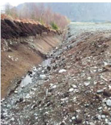
Gode undergrunnsmassar godt egna til omgraving og til bygging av driftsveggar. Frå Fræna i Møre og Romsdal. Foto Landbruk Nordvest
