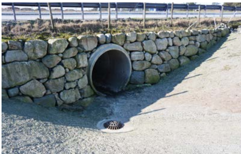
Undergang gir adgang til ammekyrbeitet på andre siden av veien.
