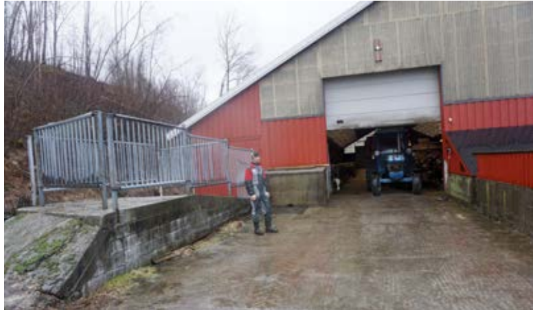
Cato Haaheim framfor fjøset og rampa. Rampa er plassert litt bort frå trafikken inn til fjøset, noko som reduserer smittefaren med strø og anna frå dyrebilen.
