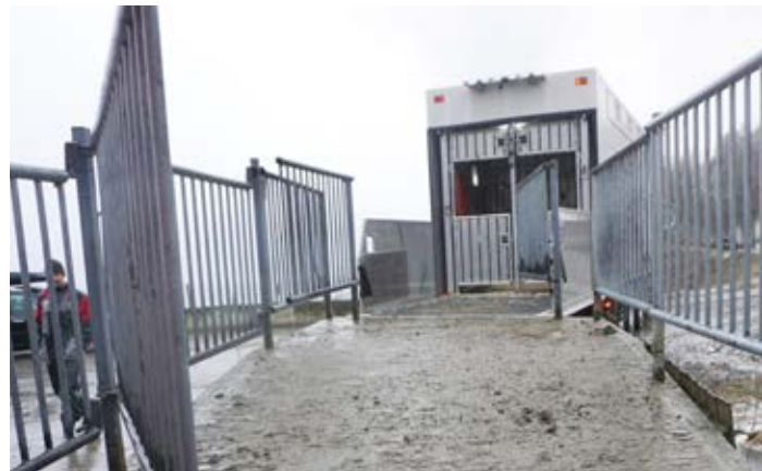
Lang rampe inndelt med grindar og grov betongstruktur.
