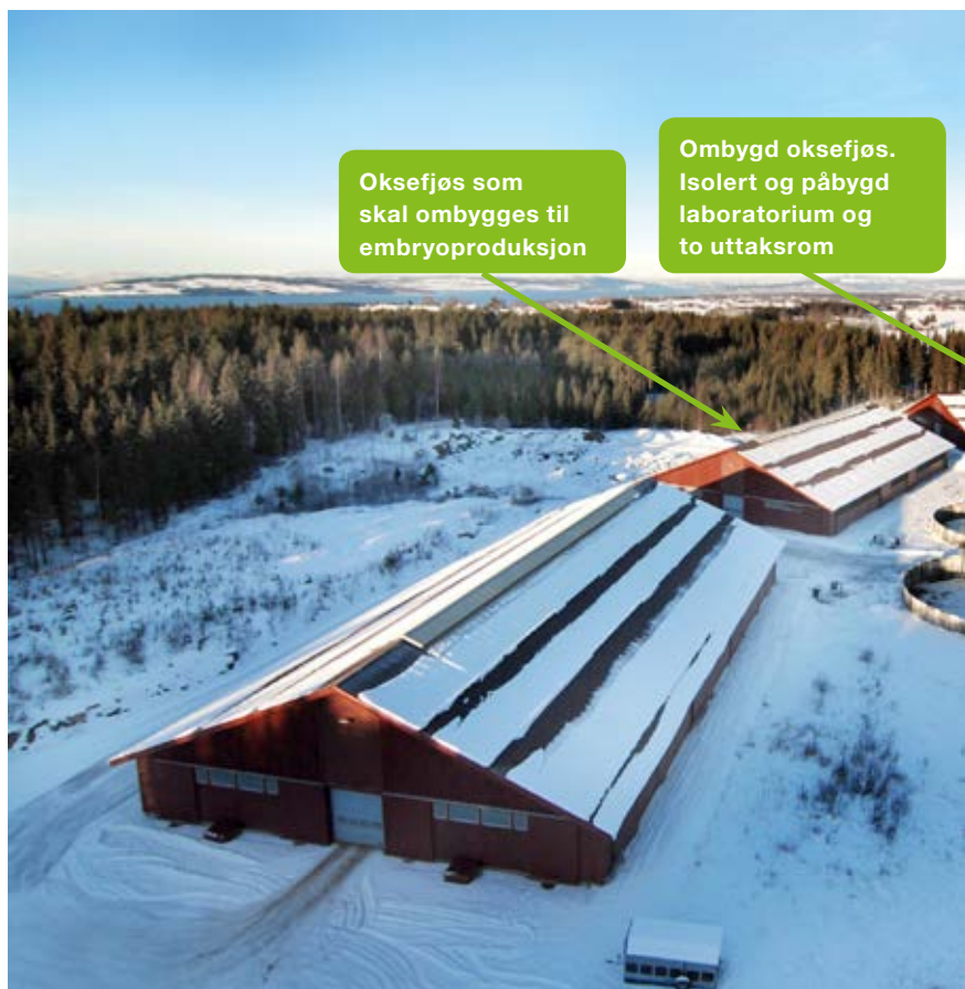
Nye tider i venteokseanlegget.
