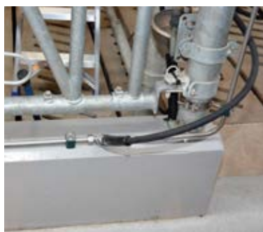
- Beste investeringen vi har gjort, sier Gerd om stasjonær høytrykksspyler med tilkoblingspunkter rundt hele fjøset.
