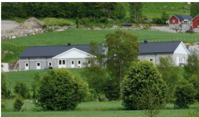
Nyfjøset plassert på sprengt tomt. Arealknapphet gjør det utenkelig å bygge på dyrket mark.
