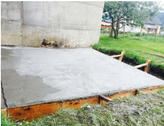
Sokkel er støypd til den nye kraftfôrsiloen.
