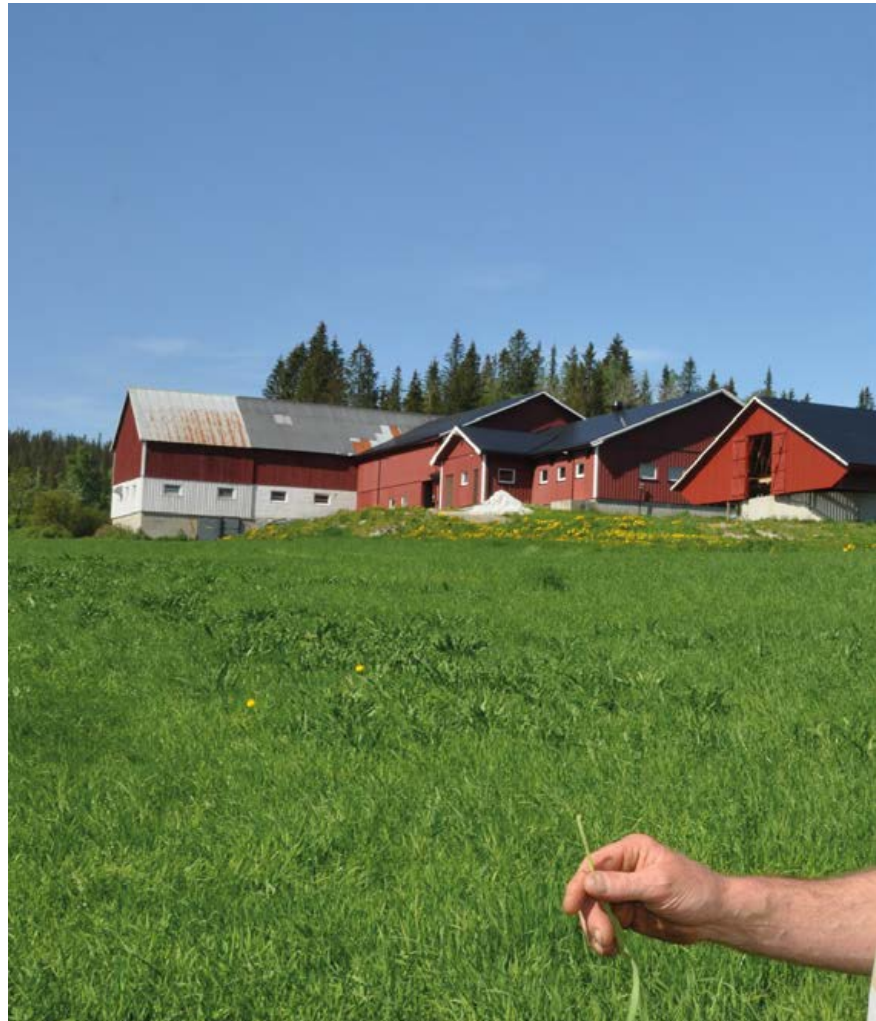
Nybygg er koblet til gammelfjøset. Det er et stort anlegg som nå skaper verdier på Utland. (Gammelfjøset har fått helt nytt tak etter at bildet ble tatt).
